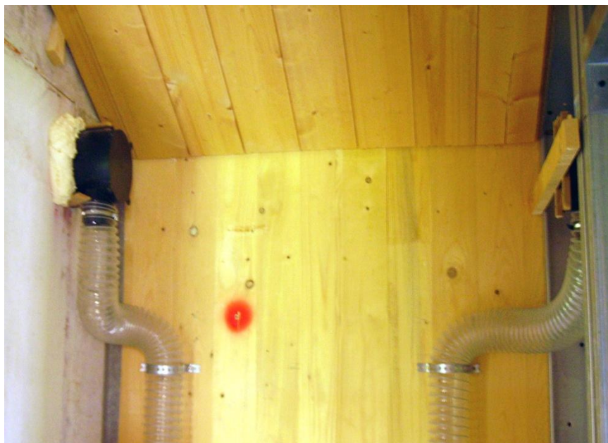
Tubazioni flessibili e bocchette di ripresa
