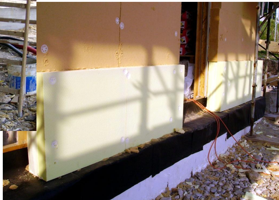
Ponte termico travi di fondazione
