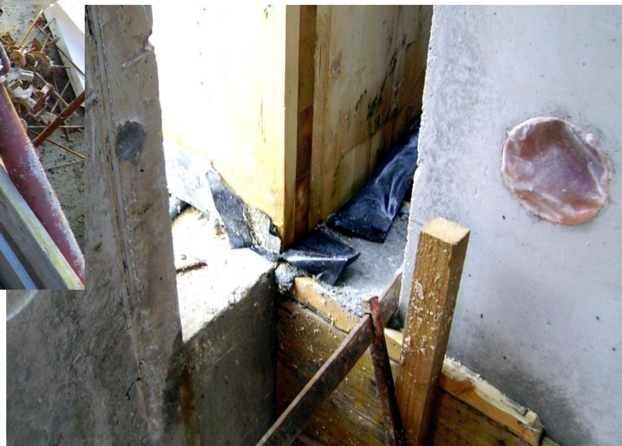
Ponte termico parete scantinato
