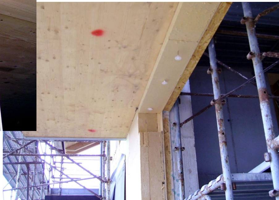
Ponte termico attacco terrazza vetrata
