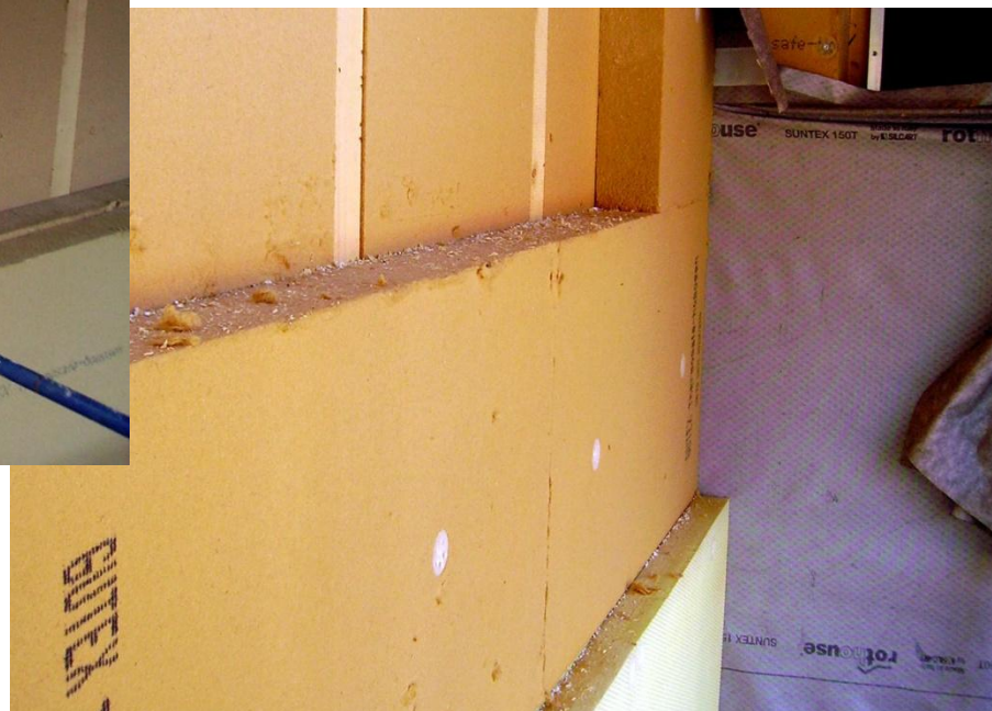
Ponte termico parete scantinato
