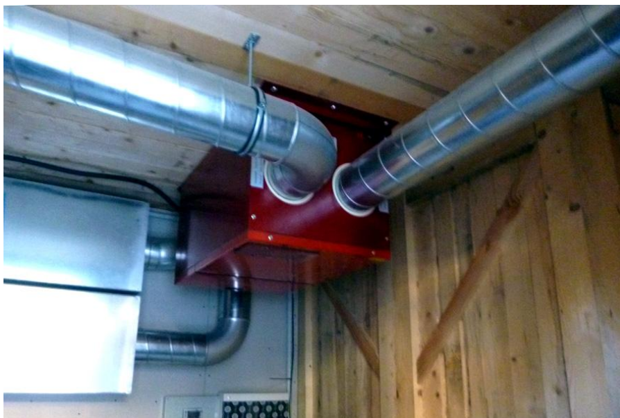
VMC entalpica senza batteria antigelo
