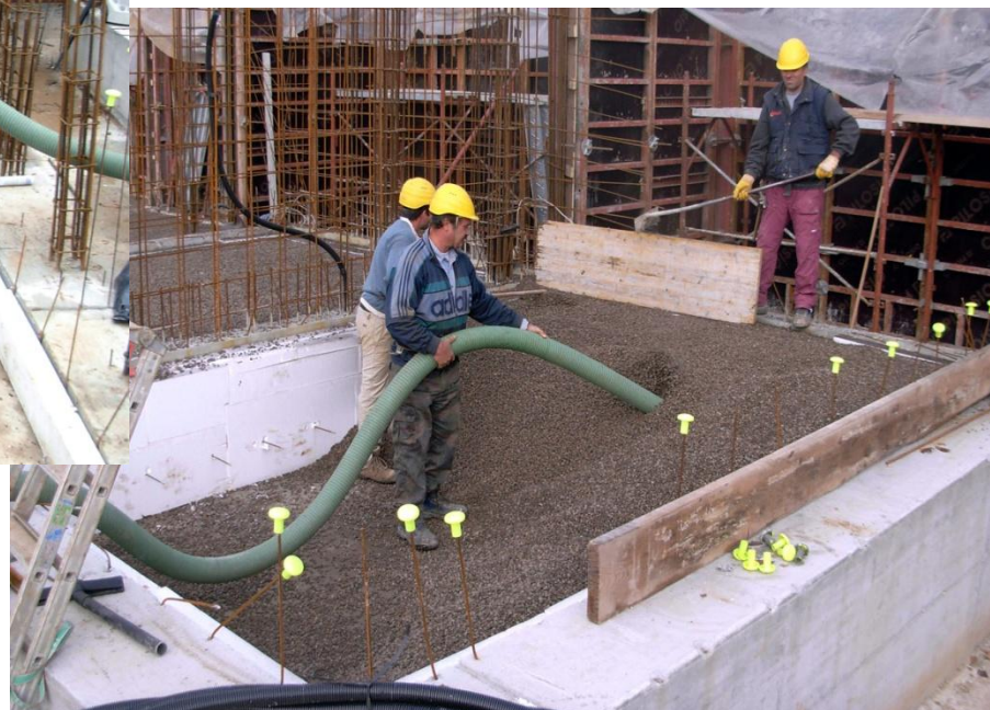
Ponte termico travi di fondazione
