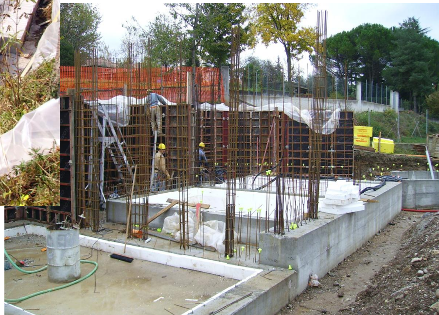
Ponte termico travi di fondazione
