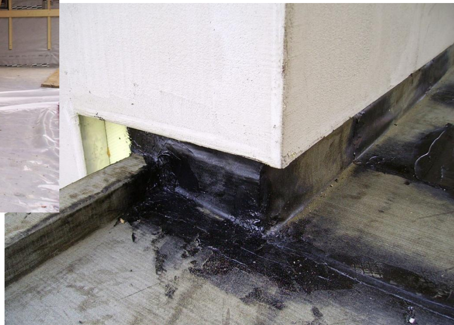
Ponte termico parete scantinato
