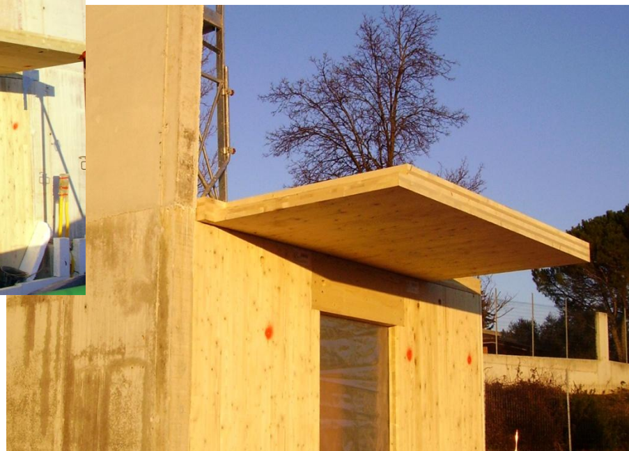
Ponte termico terrazza passante
